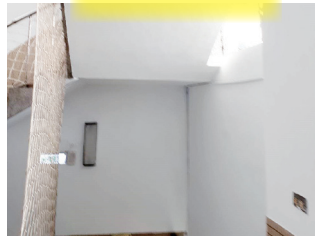
四維樓樓梯重新油漆及增設保護網 (施工後)
