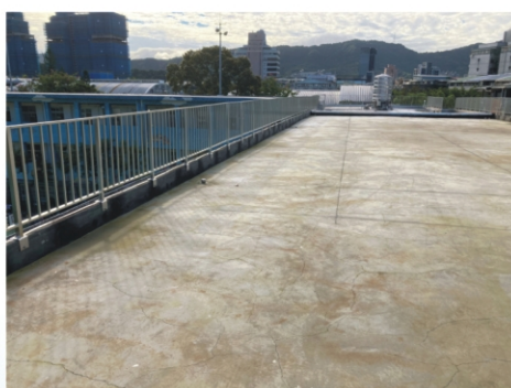
信義樓屋頂防水工程
