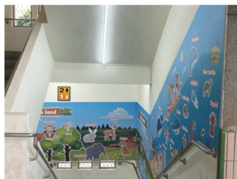
加強樓梯間照明
