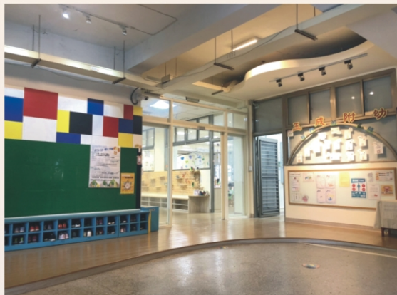
【玉成附幼陸地區大門】裝設自動鋁門，採用隱藏式地鎖及安全裝置避免夾傷。
