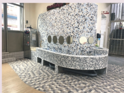
【廁所洗手台】原位於教室內洗手台，移至廁所外的公用走道，改善原先可移動式水槽原始管線設計不良的問題，並新設管線增加水龍頭數量及拖布盆設計，幼兒與老師使用上都更加方便。
