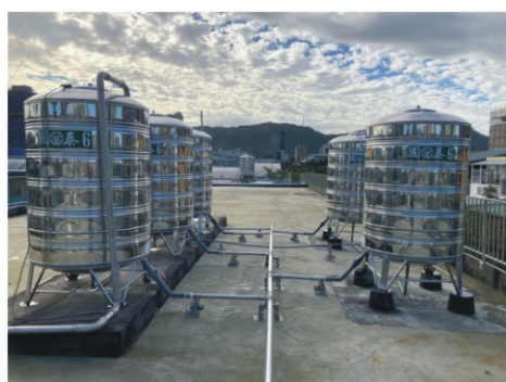
信義樓屋頂防水工程
